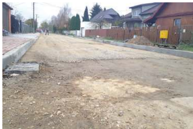
Prace nad ul. Pocztową w Gołębim trwają w najlepsze. Stary sfatygowany asfalt zastąpi nowa nawierzchnia
