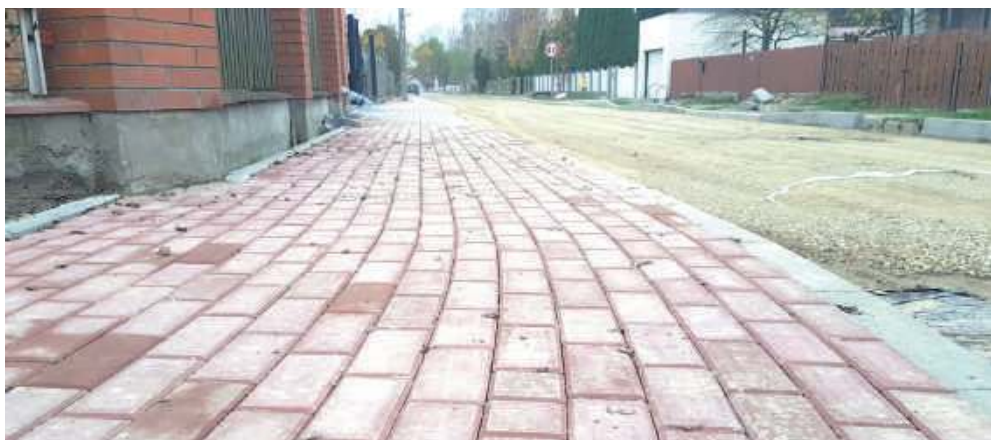
W ramach przebudowy ul. Pocztowej drogowcy budują także chodnik, którego dotąd tutaj nie było
