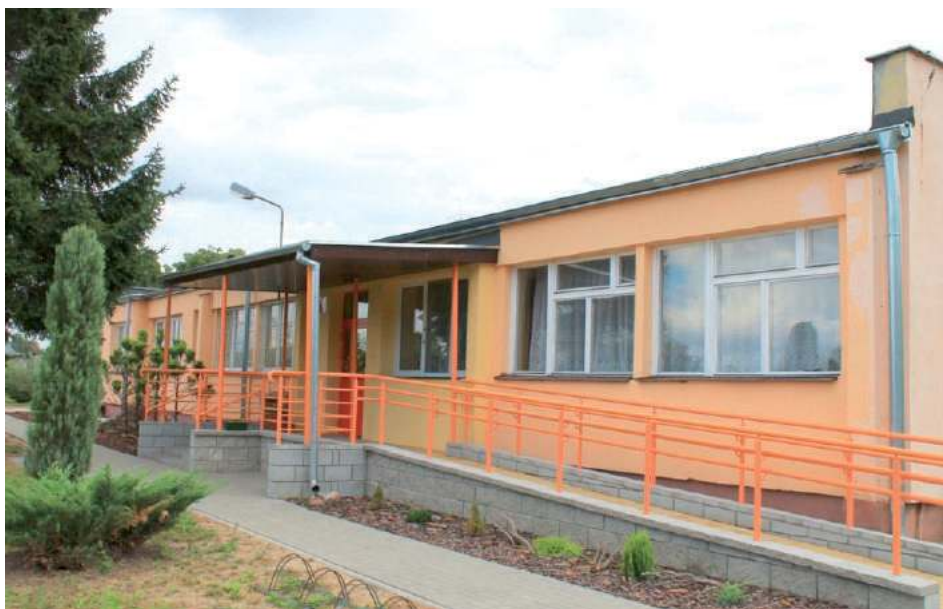
Przedszkole im. Bohaterów 3-go Pułku Piechoty I Dywizji Wojska Polskiego w Gołębiu przejdzie remont. Na razie władze gminy chcą jednak przygotować niezbędną dokumentację
