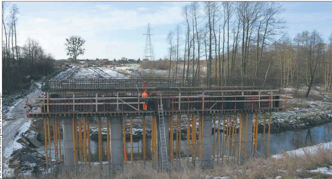
Trwa budowa obwodnicy Sierpca
