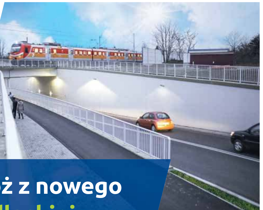
Wiadukt kolejowy nad ul. Lubelską, Biała Podlaska
