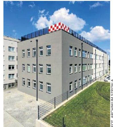
Blok operacyjny został dobudowany do istniejącego budynku „H”
