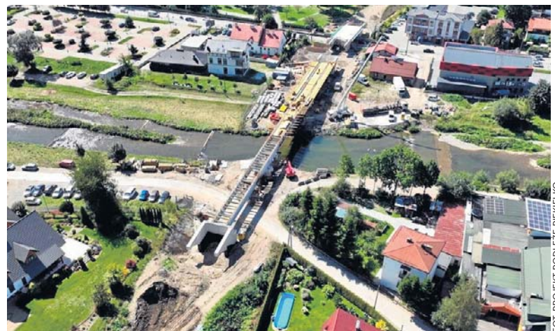
Mszana Dolna. Jednym z nowych obiektów będzie most kolejowy. Jego przeszło jest już nad Mszanką
