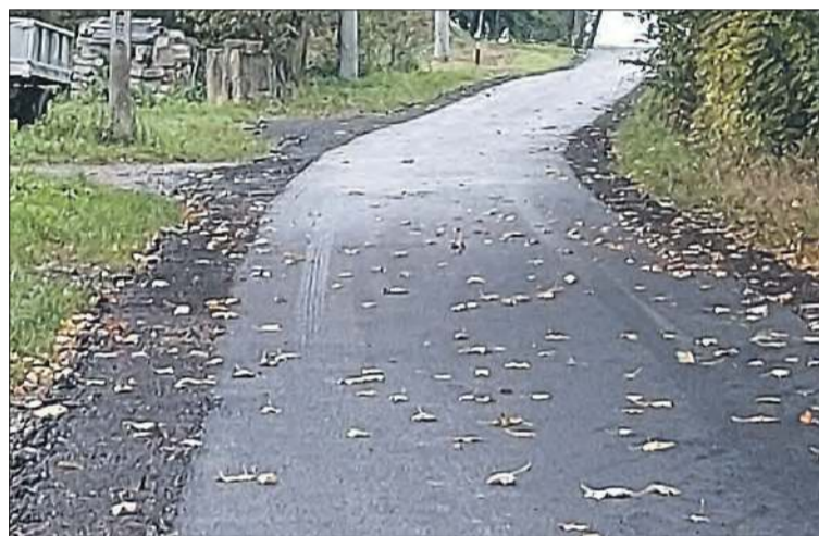
Droga gminna wyasfaltowana z funduszu sołeckiego (plus gmina)
