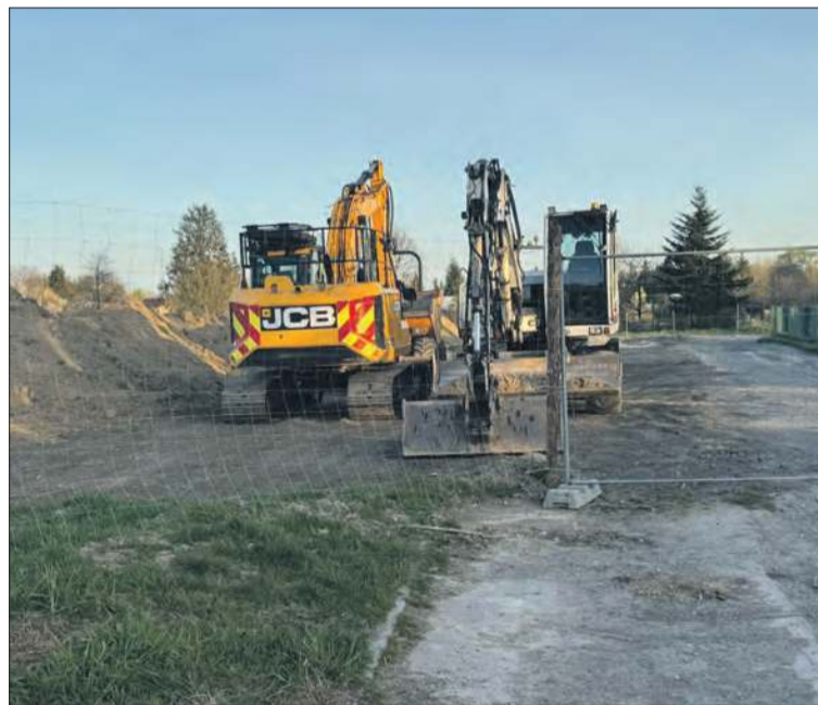
Budowa drogi od strony Prudnika
