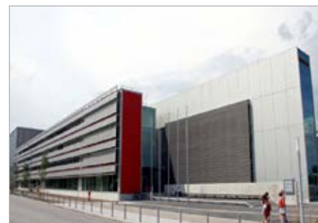
Rys. 1. Centrum przetwarzania danych Leibniz-Rechenzentrum w Garching koło Monachium
