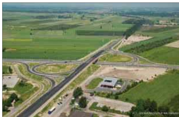
Obwodnica Białej Podlaskiej w ciągu DK2. Na północ od tego miejsca powstanie węzeł na skrzyżowaniu A2 i drogi wojewódzkiej 811
