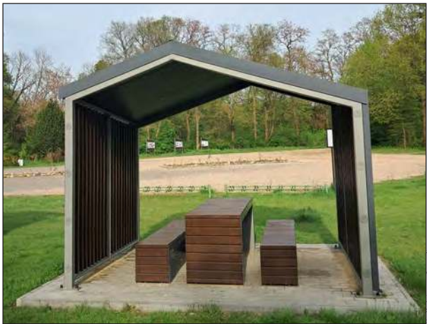
➤ Z racji upływu czasu część infrastruktury uległa naturalnemu zużyciu. Obecnie trwa jej modernizacja. Stare, przeciekające drewniane wiaty zostały zastąpione nowymi, estetycznymi konstrukcjami, które znacząco poprawiają komfort odwiedzających
