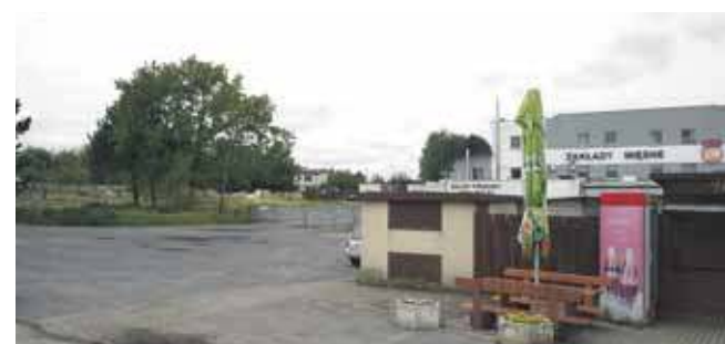
Chodzi o teren po Zakładach Mięsnych Wojtacha. Widać, że wyburzono część znajdujących się tam zabudowań
