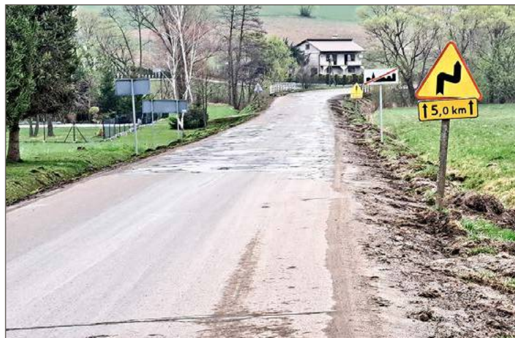
Remontowany będzie najbardziej zniszczony odcinek drogi.
