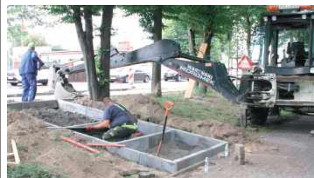
Zakończenie prac zaplanowano na połowę sierpnia
