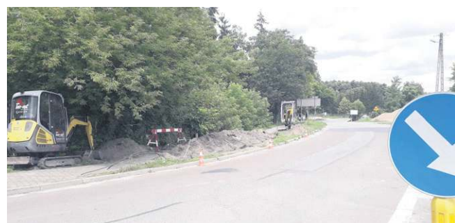
W innych miejscowościach prace trwają.
