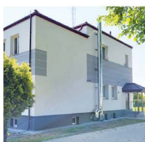
Remizo-świetlica w Ulhówku.
