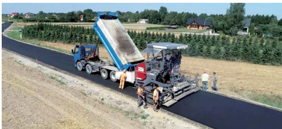
Przebudowa drogi gminnej nr 105194L w Ciechankach Krzesimowskich i Piotrówku Drugim kosztuje 2.436.881,94 zł, w tym 1.218.440,00 zł to dofinansowanie z Funduszu Dróg Samorządowych
