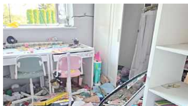
Ze wstępnych ustaleń wynika, że w budynku doszło do wybuchu ulatniającego się z butli gazu
