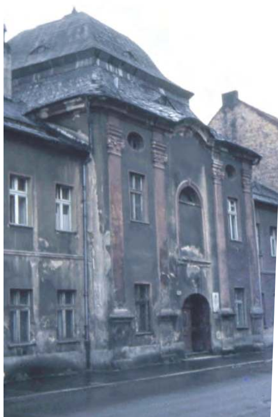
Bardzo zaniedbany budynek „zajazdu” przy ul. Piastowskiej. Lada moment miał się tam zacząć remont, który trwał latami.
