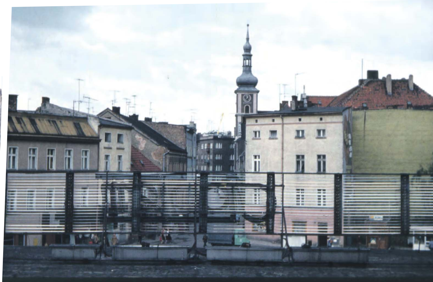
Nietypowy widok znad pawilonu handlowego w kierunku kościoła bonifratrów
