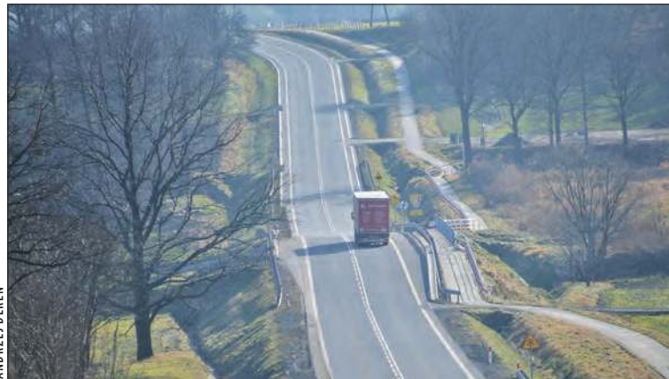
Obwodnica powstanie w ciągu drogi krajowej nr 41
