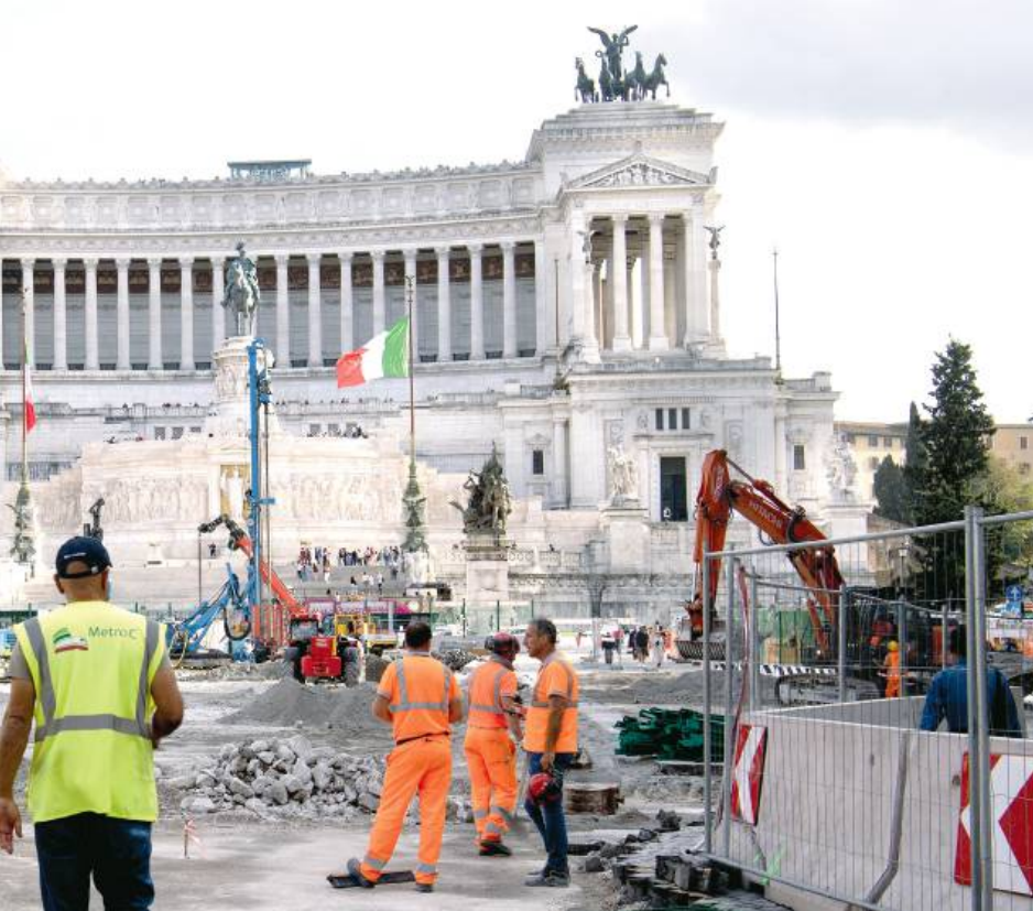
Plac Wenecki cały w przebudowie.
