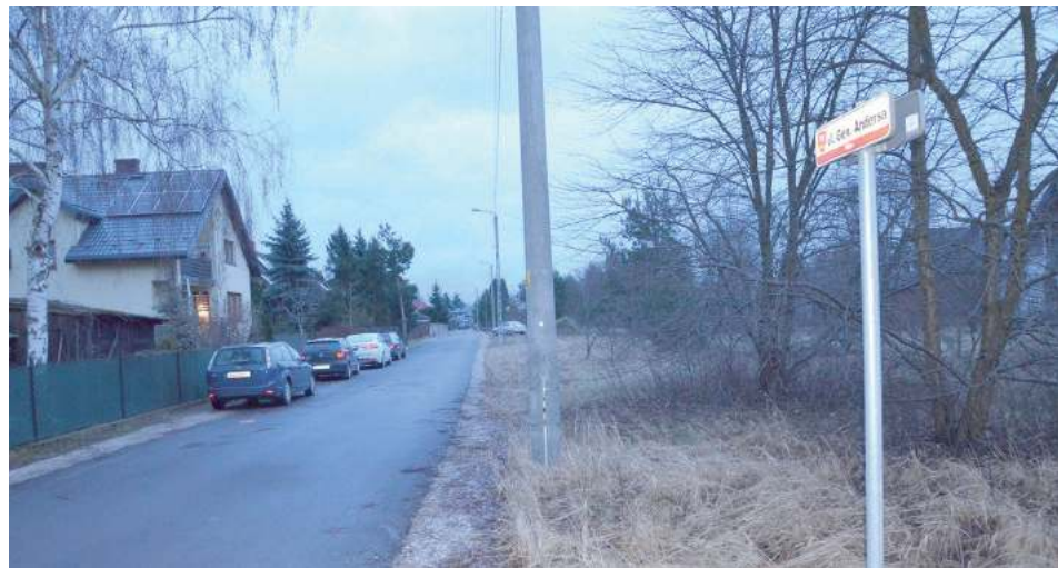
Na ul. Andersa w Wildze został położony asfalt. Tylko jedna warstwa, bo niedługo pod nią będą robić kanalizację
