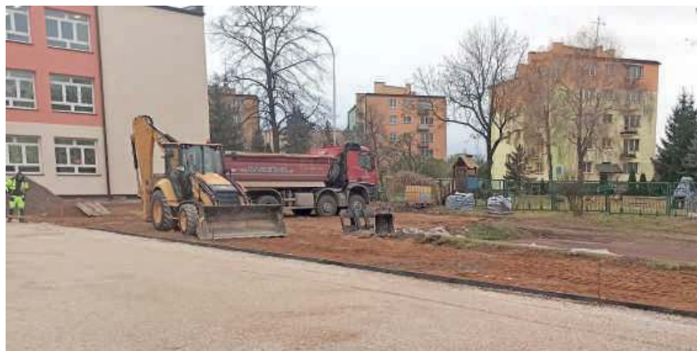
Prace już trwają
