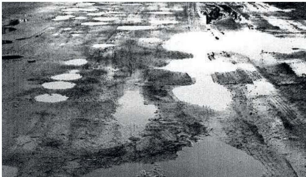
Droga jest w fatalnym stanie
