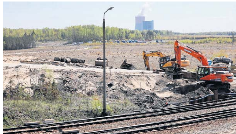
Teren pod fabrykę polskiego elektryka. Zdjęcie z kwietnia br.
