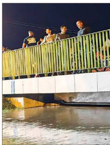
Bobrowa - woda sięgała dźwigarów mostu.
