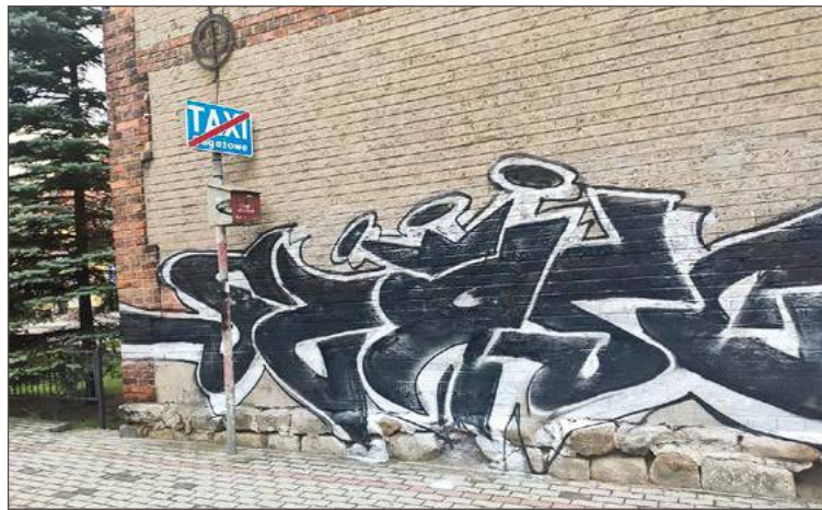
Dzisiaj tego malowidła już nie ma, ale czyszczenie elewacji poprzedziły konsultacje z konserwatorem zabytków.
