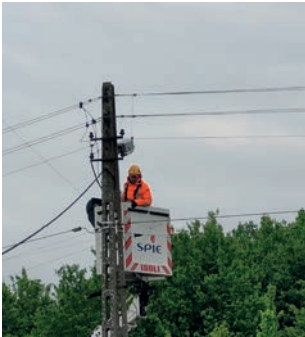
Wymiana jednej lampy trwa ok. 10 minut
