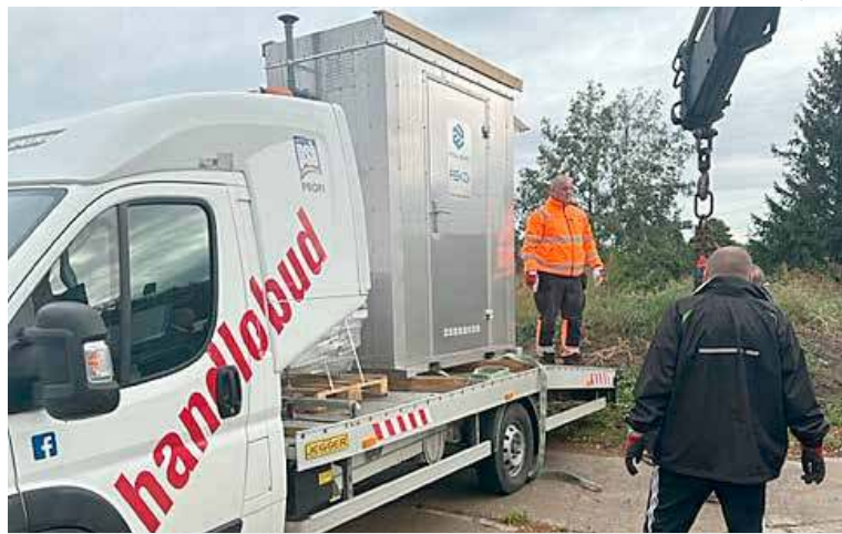
Zlewnia podczas montażu (fot. Gm. Stepnica)
