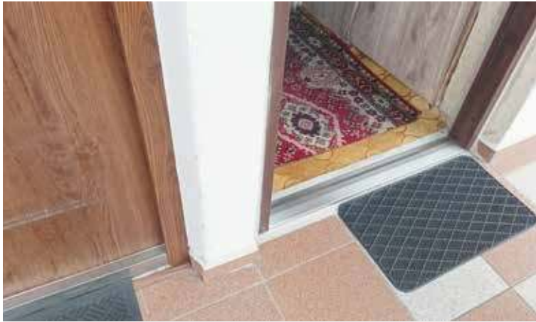
Podczas ulew woda przelewa się przez niski próg do mieszkania
