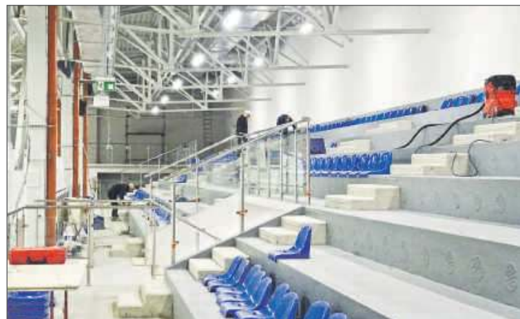
Ostatnie prace na lodowisku przy ul. Piłsudskiego.
