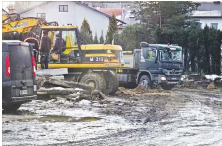
Przy ul. Poddęby pracuje już ciężki sprzęt.
