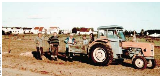
Chwile przed rozpoczęciem budowy kościoła w Jamielniku
