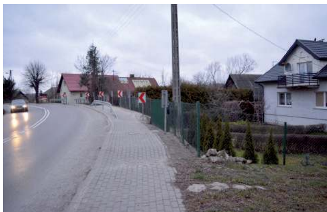
W trosce o bezpieczeństwo pieszych korzystających z chodnika, okolicznych mieszkańców, ale i samych kierowców przekraczających prędkość na zakręcie ustawiono metalową barierę, ostrzegawcze, czerwone pasy wibracyjne oraz poszerzono chodnik
