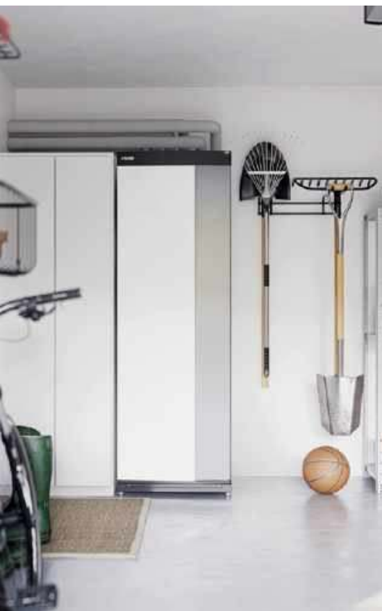
Zbiornik c.w.u. po prostu musi być duży. Często jest nawet dwa razy większy, niż w analogicznym układzie z kotłem. NIBE-BIAWAR
