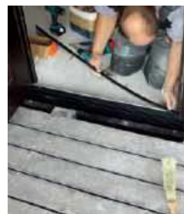
📌 Osadzenie progu izolującego termicznie wylewkę za drzwiami. CAL
