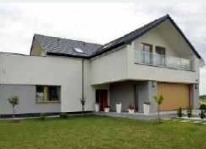
🔗 Dwuwarstwowy mur wykończono tynkiem silikonowym w dwóch kolorach.
