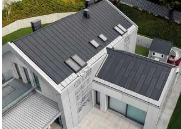
☛ Dach pokryty panelami PV zintegrowanymi z blachą płaską, układaną na rąbek stojący, tworzy jednolitą powierzchnię. Panele są prawie niewidoczne. BP2
