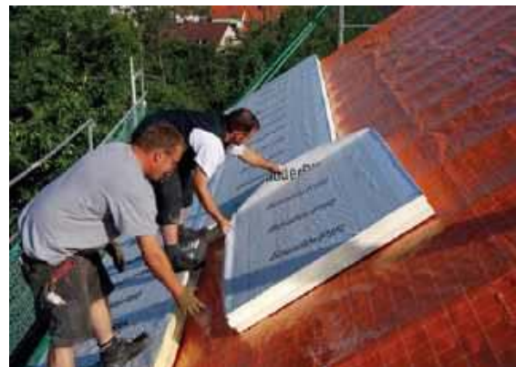
Izolację nakrokwiową układa się od okapu w górę. BAUDER
