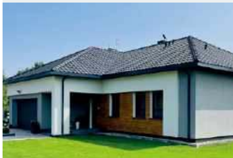
Elewację wykończono cienkowarstwowym tynkiem silikatowym i drewnopodobną okładziną akrylową.
