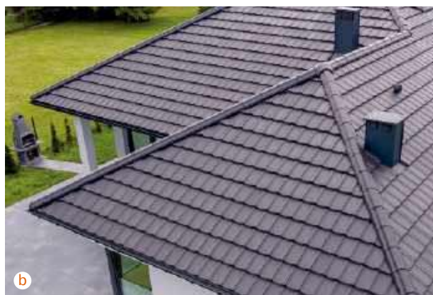
Dach pokryty dachówką ceramiczną w kolorze grafitowym – angobowaną (a WIENERBERGER) i glazurowaną (b CREATON POLSKA).
