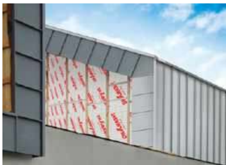
📌 Płytami PIR ociepla się dachy i ściany. BALEX METAL
