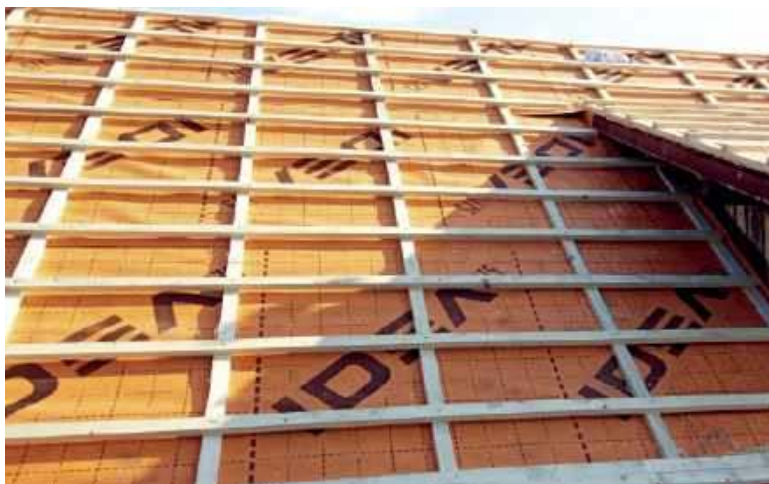
🔗 Niezbędnym elementem podkładu jest folia lub membrana, których użycie zapobiega zawilgoceniu konstrukcji i izolacji dachu. MARMA POLSKIE FOLIE
