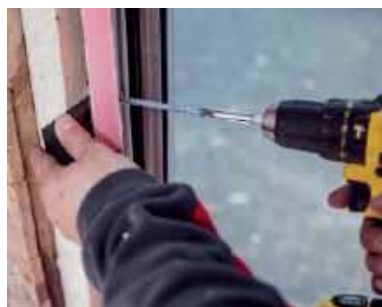
📌 Przymocowanie ościeżnicy do ściany za pomocą kołków lub kotew – rozmieszcza się je po 3 na bok. DOBRY MONTAŻ
