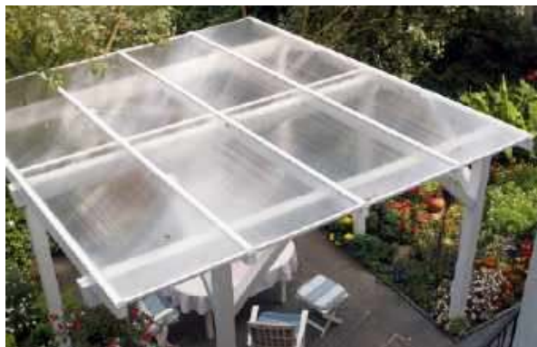
➡ Dach z poliwęglanu na konstrukcji drewnianej. GUTTA
