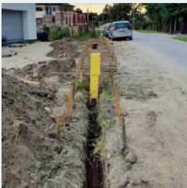
➤ Wykonanie wykopu i deskowania pod fundament żelbetowy.
