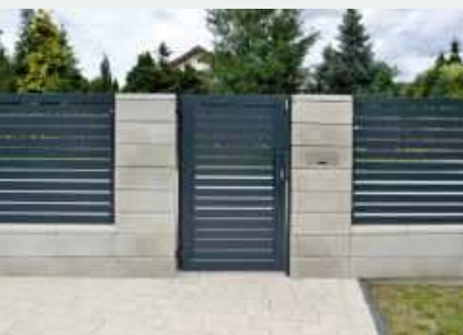
➔ Ogrodzenie frontowe wykonano z kształtek betonowych i przęsła ze stali.
