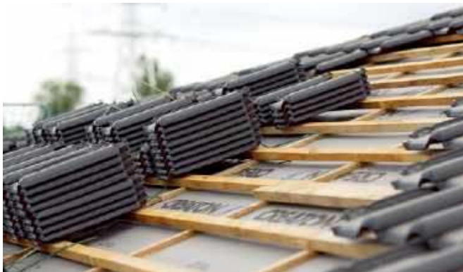
🔗 Pokrycia ciężkie, np. dachówki, można układać tylko na odpowiednio wytrzymałych konstrukcjach. CREATON POLSKA
