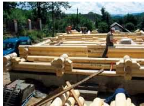
🔗 Klasyczna ściana z bala – taka nie spełnia dziś wymogów dotyczących ciepłochronności przegród. ARCHIWUM BD
