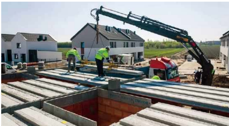
🔗 Największą zaletą stropów panelowych jest szybki montaż. Co istotne, nie potrzeba do niego ciężkiego sprzętu – wystarczy samochód z lekkim dźwigiem typu HDS. STROPY.PL
