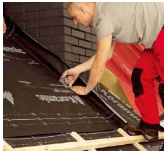
Montaż membrany dachowej. WIENERBERGER
