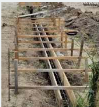
➤ Wykonanie wykopu i deskowania pod fundament żelbetowy.
