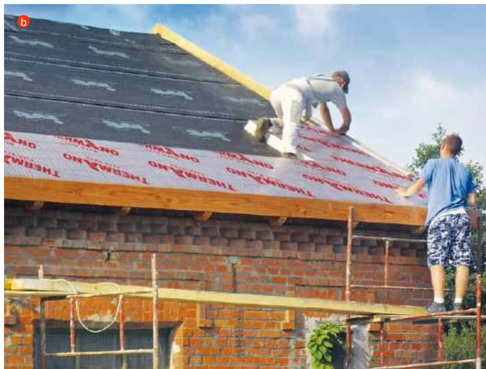
📌 Izolacja nakrokwiowa sprawdza się w budynkach nowych (a) i modernizowanych (b). BALEX METAL
