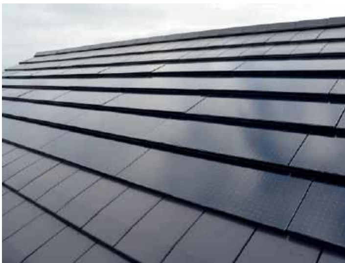
☛ Dach solarny 2 w 1 pokryty zintegrowaną dachówką. WIENERBERGER
