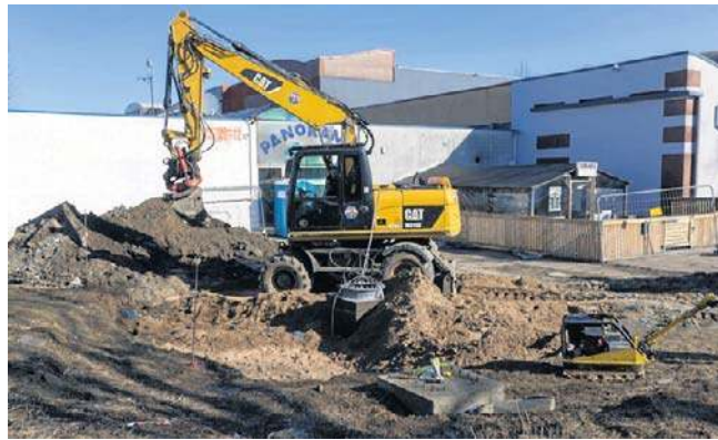
Budowa maszty stacji bazowej P4 przy ul. Tuwima
