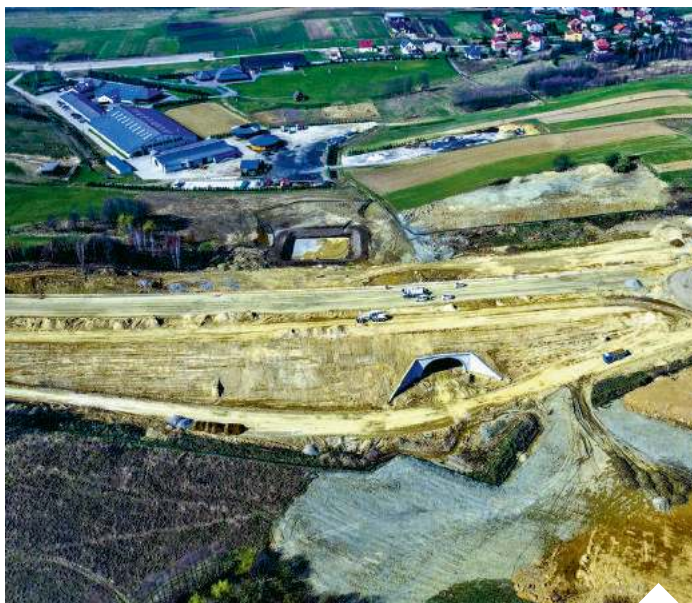
Trwa budowa międzynarodowej drogi Via Carpatia | fot. mat. pras./d
