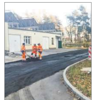
Prace przy szpitalu są w toku.
