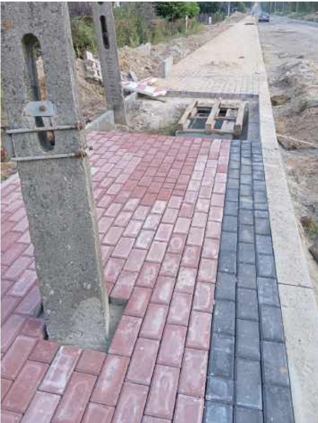
Braki w nawierzchni mają pozwolić na usunięcie starego słupa
