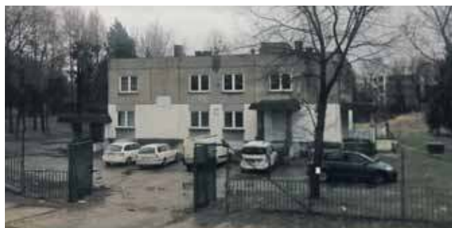
Miejski żłobek powstanie w miejscu budynku Iskry Lasowice, który zostanie wyburzony
