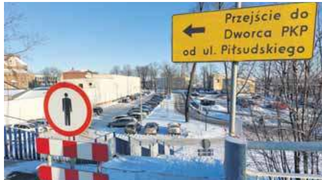
Zgodnie z tablicą informacyjną, aby dojść do widocznego z wiaduktu dworca kolejowego, należy sporo nadrobić, idąc ul. Piłsudskiego
