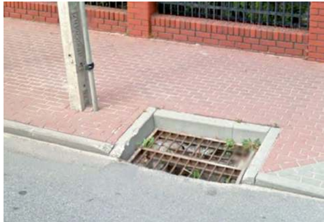
Widok studzienki sprzed 3 lat
