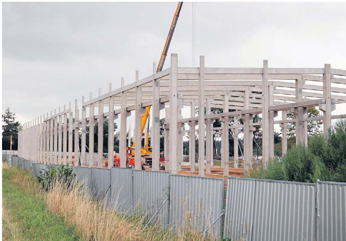
W Starochęcinach przy starej „siódemce” powstaje ogromna hala produkcyjna. To inwestycja firmy Tawol, która od lat działa w Chęcinach. W zakładzie mają powstawać stalowe elementy i konstrukcje
