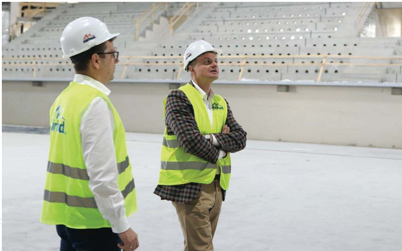
Wicemarszałek Marcin Kuchciński na budowie nowej Uranii, na którą Olsztyn otrzymał 116 mln zł dofinansowania z RPO WiM na lata 2014-2020. Hala ma być gotowa w październiku.
