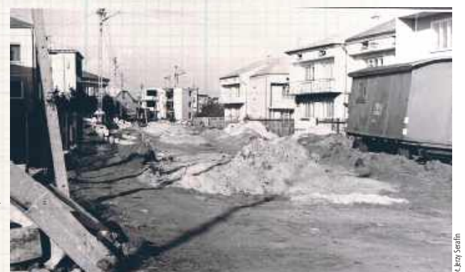
Budowa ulicy na osiedlu domków jednorodzinnych - Sitarska w Biłgoraju
