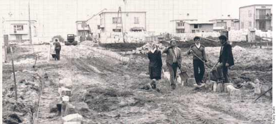
Budowa Osiedla Kępy
