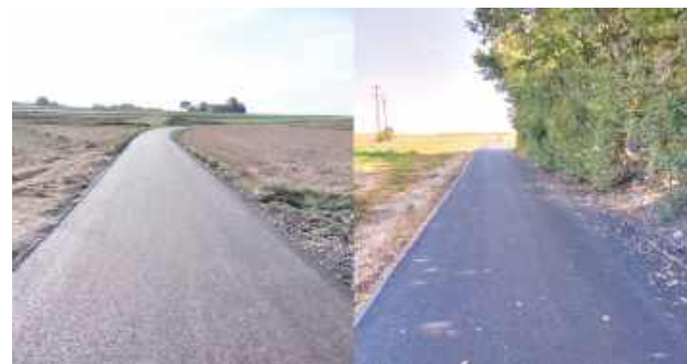
Oddana właśnie do użytku droga, połączyła Żabno-Kolonię z Czerniecinem Głównym i skróci dojazd do Zamościa
