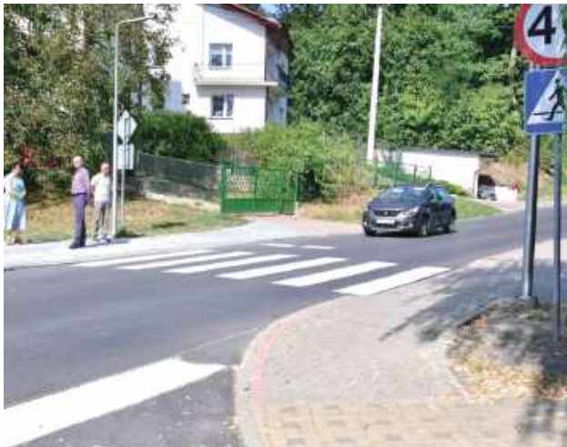
Ponad kilometrowy odcinek przebudowanej drogi łączy: Łukowę, Księżpol i Tarnogród
