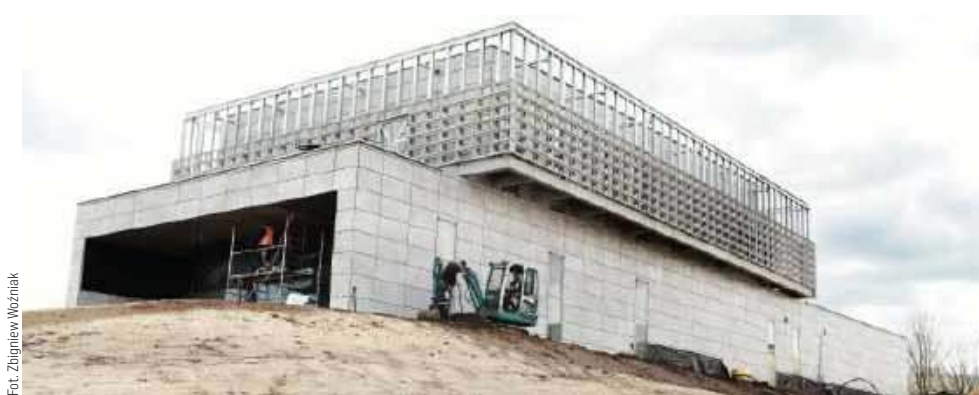
Trwa budowa nowej siedziby Polikliniki Wyjazdowej Dużych Zwierząt UWM
