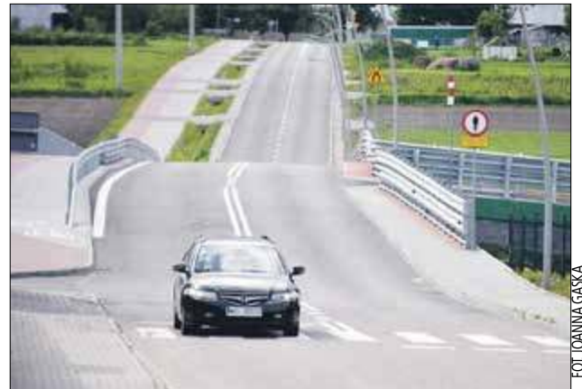
Zeszły rok był niewątpliwie dla miasta i gminy rokiem inwestycji w infrastrukturę, została m.in. zakończona długo wyczekiwana budowa mostu na rzece Tocznej w ciągu ulicy Myśliwskiej
