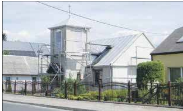
Prace remontowe przy Centrum Kultury Prawosławnej potrwać jeszcze rok
