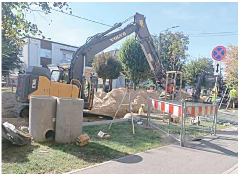
14 sierpnia prace prowadzone były przy starej mleczarni
