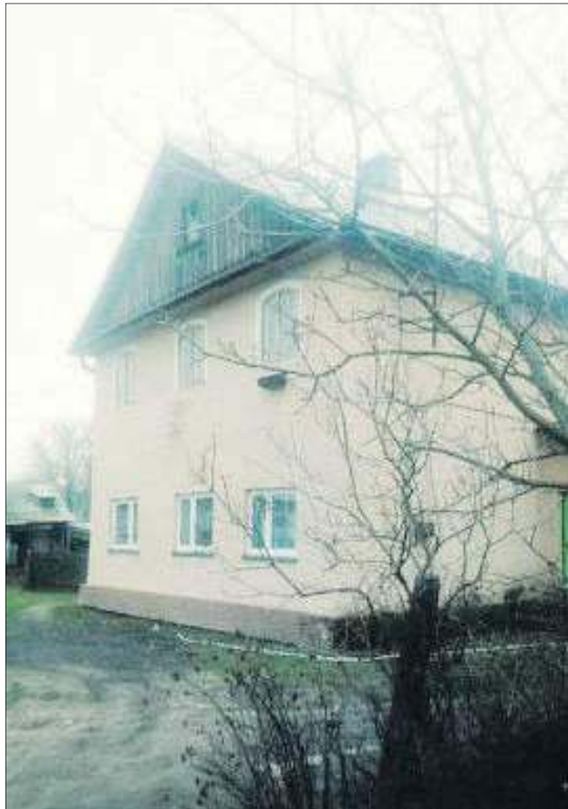
Mieszkańcy budynku przy ul. Bialskiej 15 narzekają na brak kanalizacji i niebezpieczne schody na klatce, z tego powodu powiadomili prokuraturę
