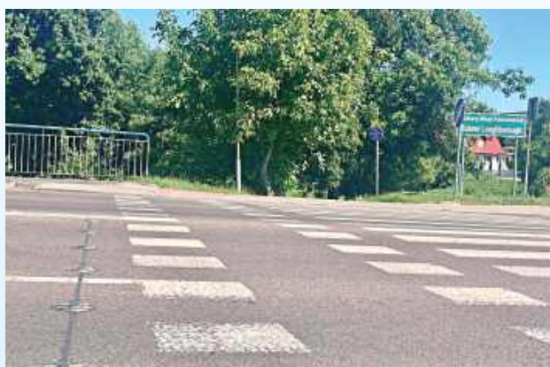
Bezpieczne przejście dla pieszych powstaje przy ulicy Sadowej w Zamościu
