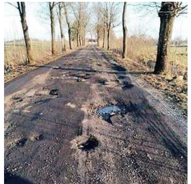
Odcinek drogi Prosimy - Księżno, gmina Bisztynek powiat bartoszycki
