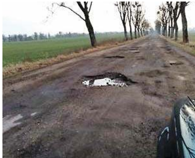
Droga na odcinku Dzikowina Babiniec, gmina Korsze
