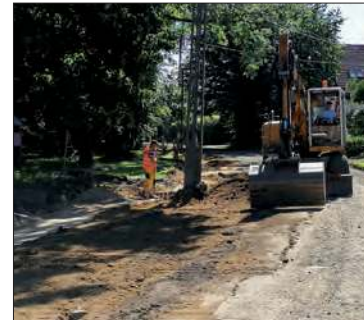
Prace na drodze Skrzypiec-Trzebina
