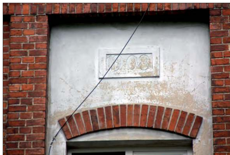
Nad oknem data budowy
