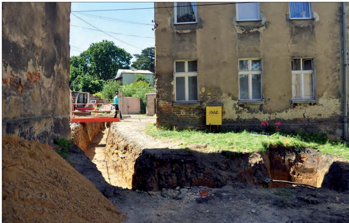
Prace przyłączeniowe do sieci ciepłowniczej ZEC-u
