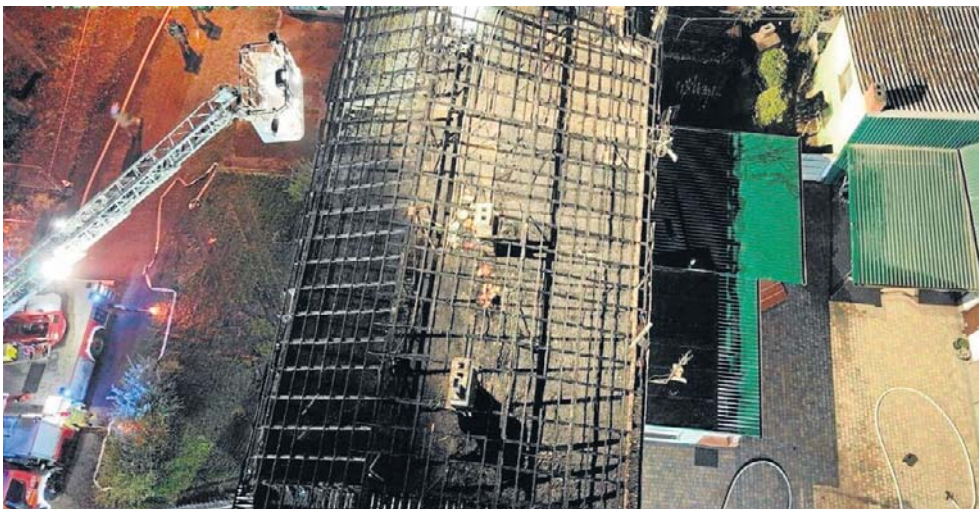
Spaleniu uległo poddasze o konstrukcji drewnianej, obejmujące powierzchnię około 380 metrów kwadratowych, a także klatka schodowa
