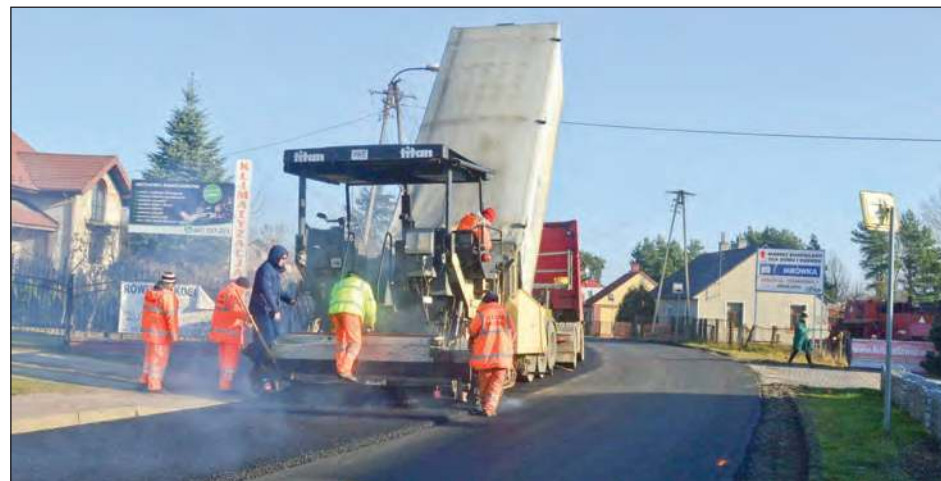
Obecnie kładzione są warstwy bitumiczne, a na wiosnę zostaną przebudowane zjazdy, zatoki autobusowe i stanowiska postojowe (zdj. Starostwo Powiatowe w Rykach)
