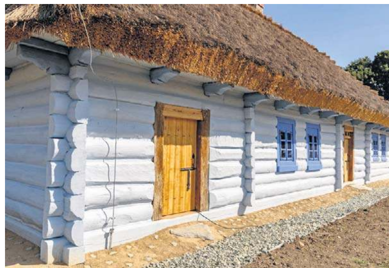
Tak prezentuje się chałupa z Pleszowa przeniesiona i zrekonstruowana z wykorzystaniem większości oryginalnych elementów
