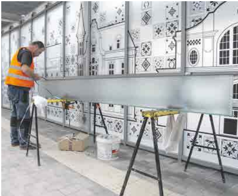
Koszty naprawy zniszczeń są wysokie
