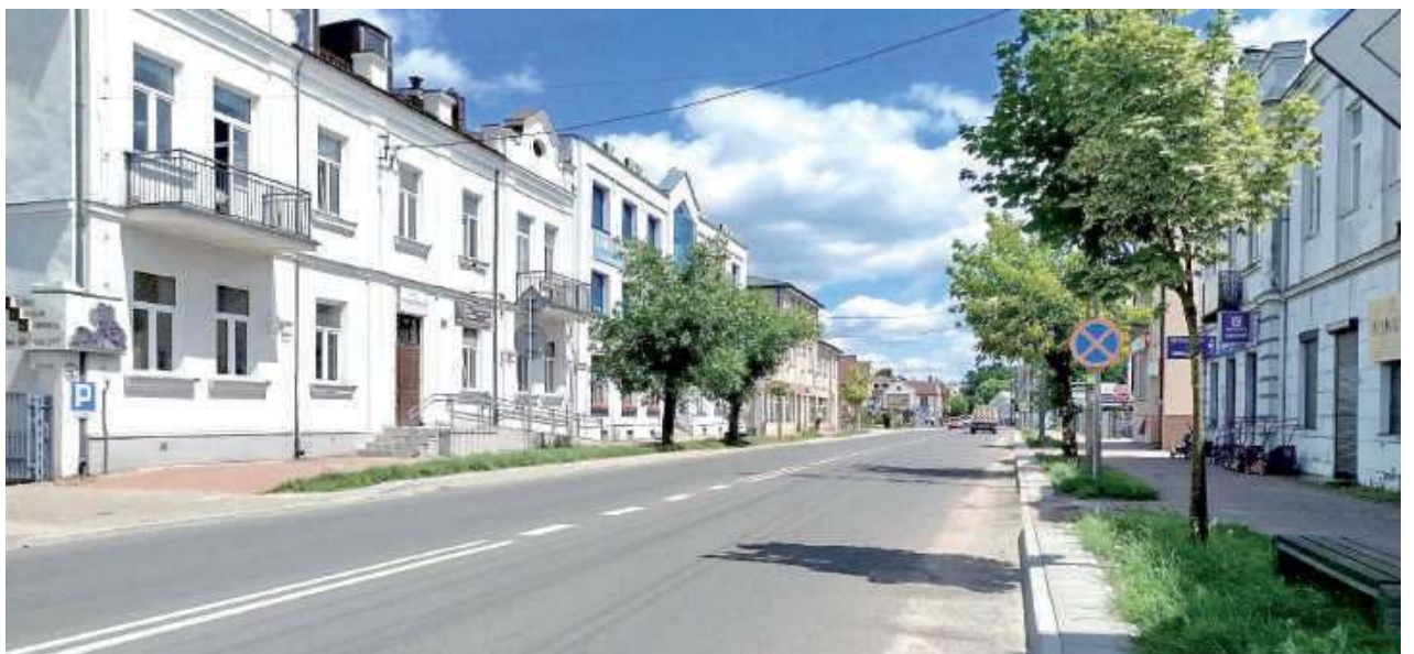
Nowa nawierzchnia pojawiła się na odcinku ul. Lubelskiej - od wyjazdu z ul. Partyzantów do końca mostu na Lubelskiej
