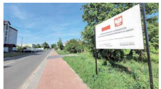
Na ul. Leśnej powstał chodnik, dzięki któremu bezpieczniej będzie można dotrzeć do ZPO nr 3
