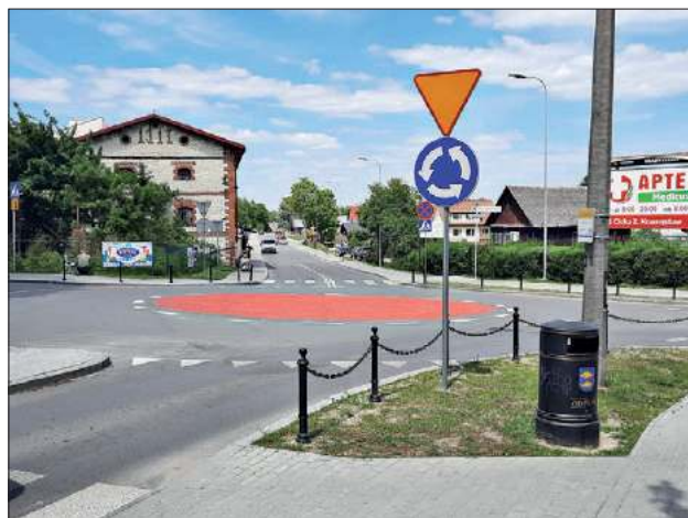
Przebudowane skrzyżowanie ulic Szkolnej, Mickiewicz i Poniatowskiego
