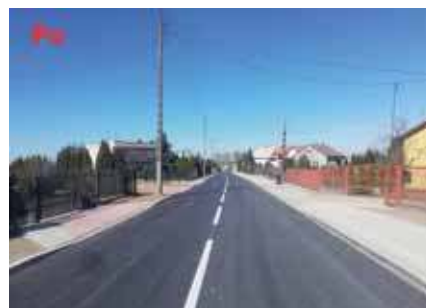
Białowiejska po przebudowie
